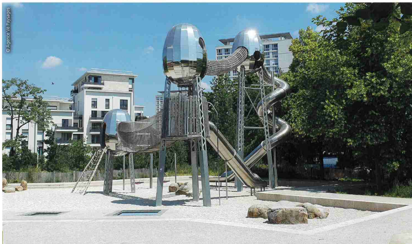
Conçue à l'échelle de l'oiseau-pylône, dans l'intention d'affirmer le caractère du parc, l'aire de jeux centrale se compose de trois œufs en inox et acier galvanisé, au design futuriste, suspendus à différentes hauteurs. L'ensemble atteint 13 mètres de haut.
