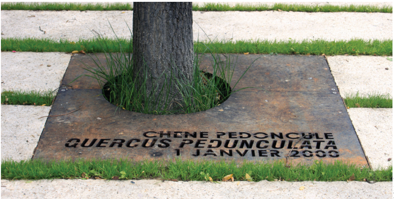
La grille, épaisse de 10 mm, s'insère dans le calepinage composé de bande de béton désactivé et les lignes de gazon.
