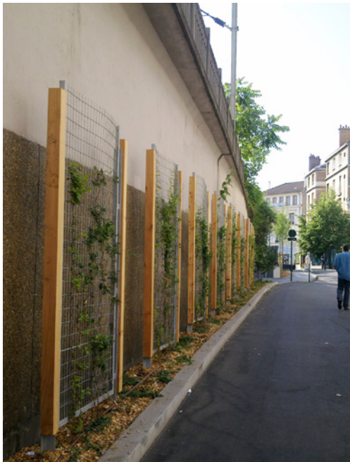
Les plantations lors de la première année le long d'un mur SNCF
