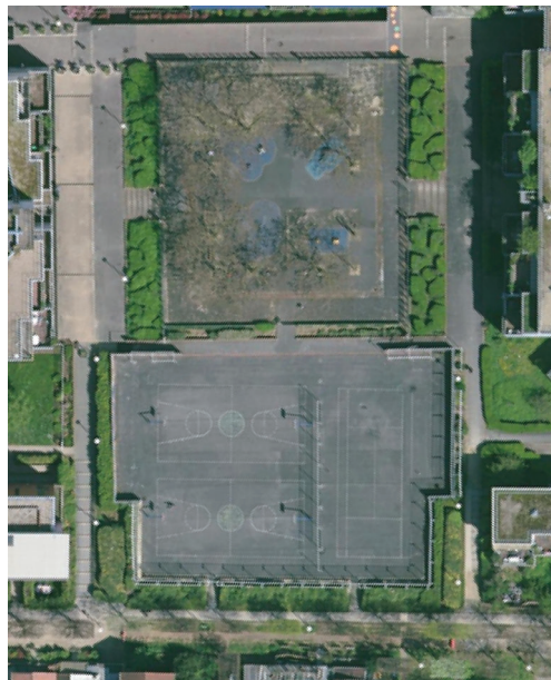
Vue avant /après l'intervention sur site
