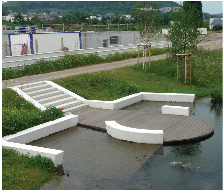
Le ponton en cours de mise en oeuvre subit sa première crue.
