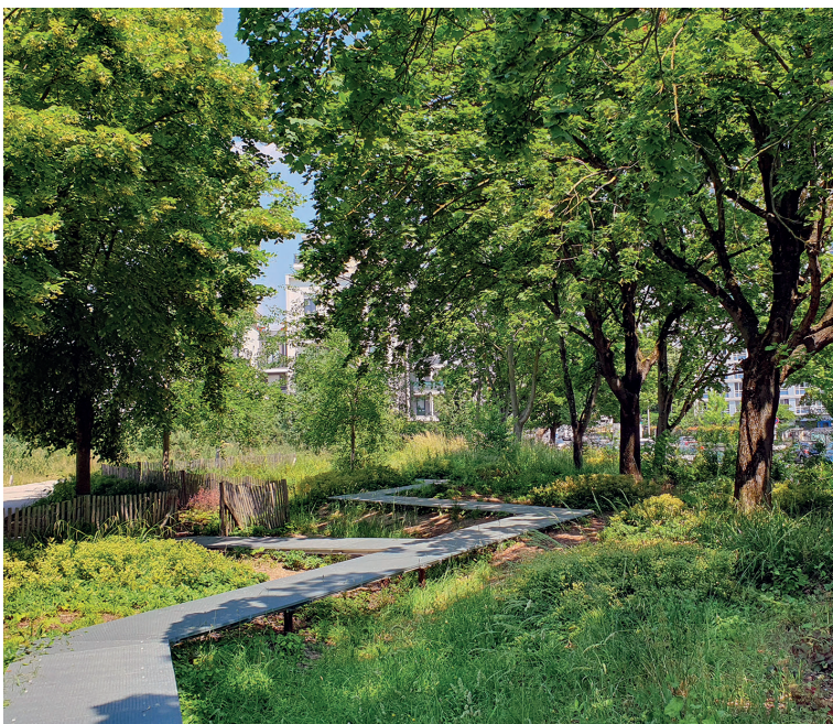
Un cheminement en caillebotis métallique surélevé sous les arbres conservés.
